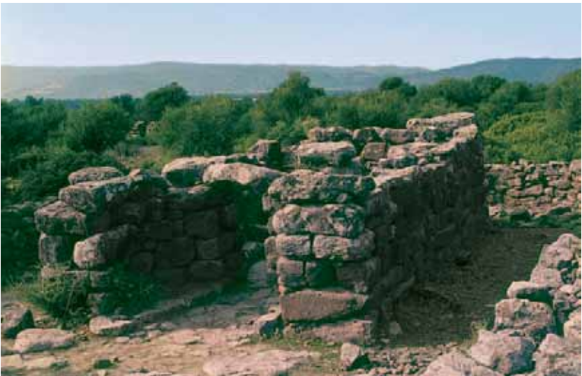
Fig. 53 Il Tempio B: particolare del prospetto con ingresso munito di architrave.
