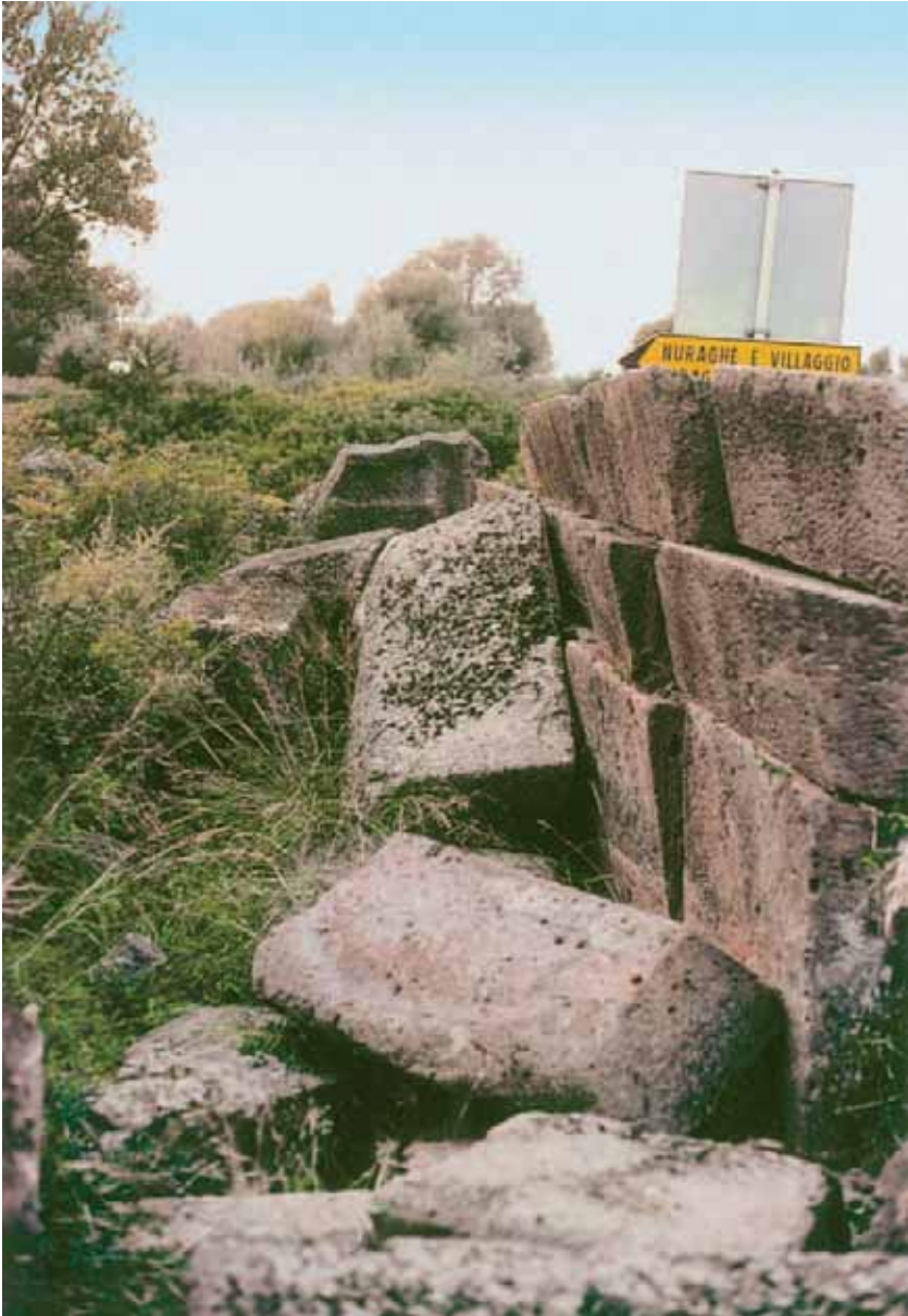
Fig. 67 Tomba di giganti di Biristeddi I: stato attuale del corridoio funerario (!).
