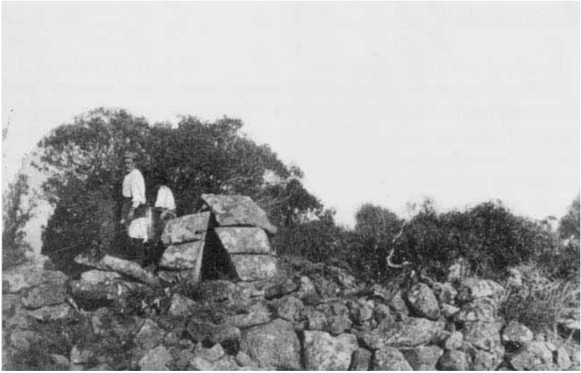
Fig. 65 Tomba di giganti di Biristeddi I: il corridoio funerario con ancora la copertura integra in una foto degli anni Trenta.
