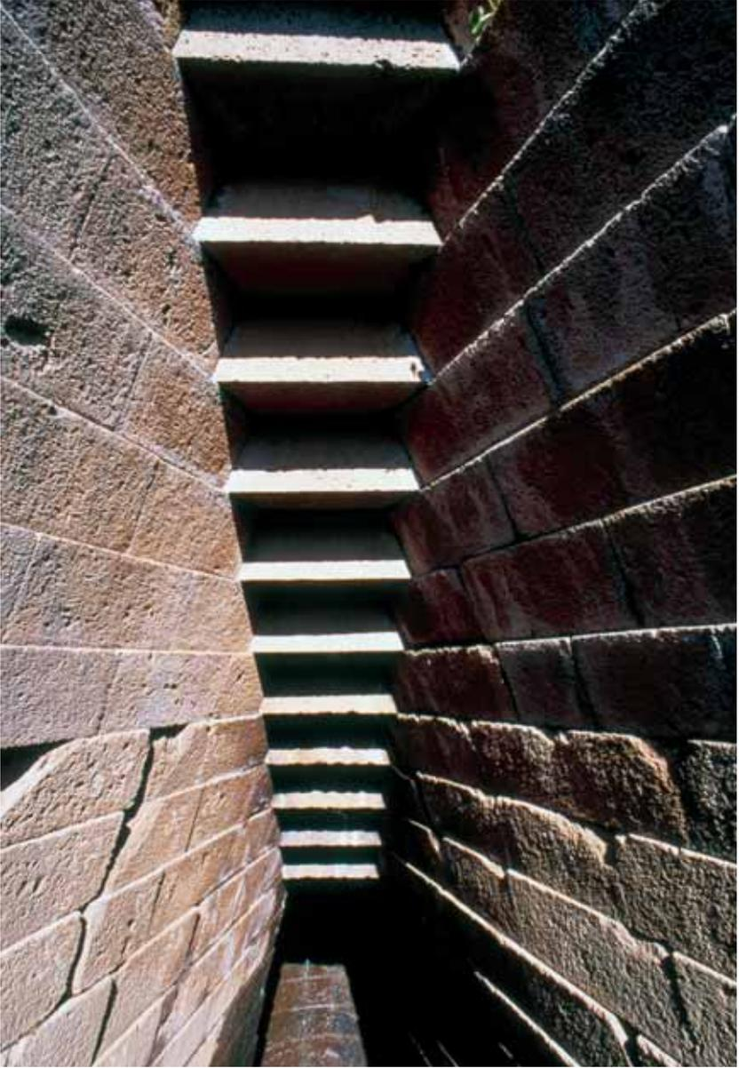
**Fig. 14.** *Copertura del vano-scala.*
